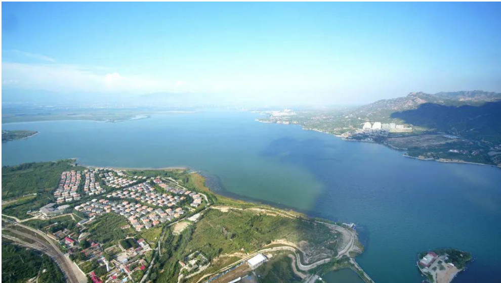
中国交建永定河流域生态治理与综合修复
