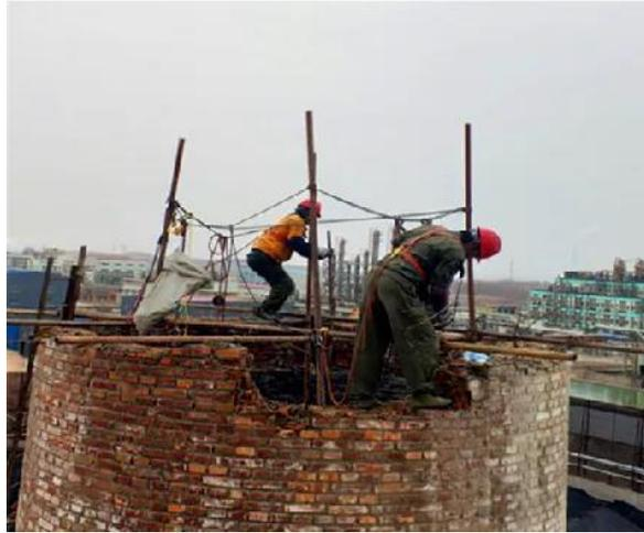
人工拆除：施工人员使用小型机具或手持工具，将拟拆除物拆解、破碎、清除。
