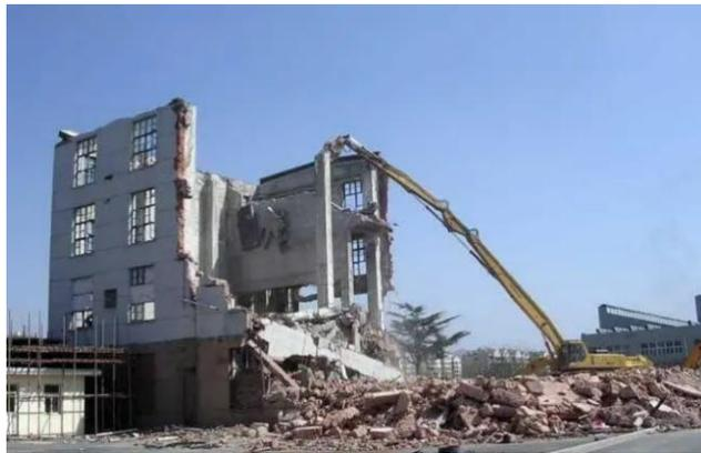
机械拆除：采用气锤、冲击锤及液压臂等机械设备，将拟拆除物拆解、破碎、清除。
