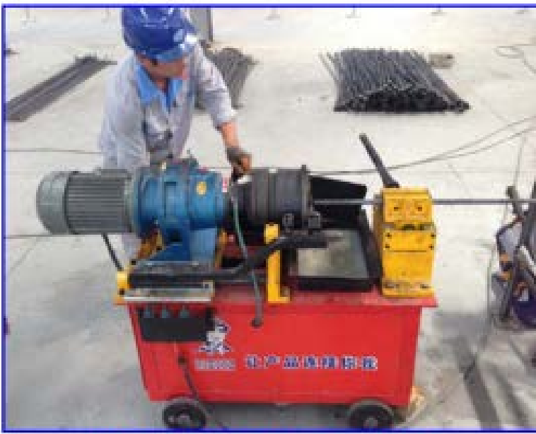
钢筋剥肋辊轧加工丝头
